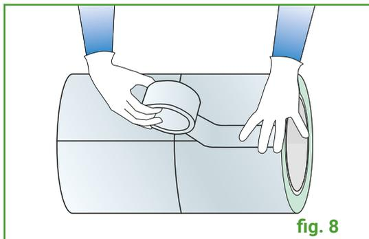
Premere i due lembi di materiale precedentemente spalmati con la colla per realizzare il giunto, e rifinire con fasce adesive e nastri idonei, della stessa finitura superficiale del materiale installato (**fig. 8**).
