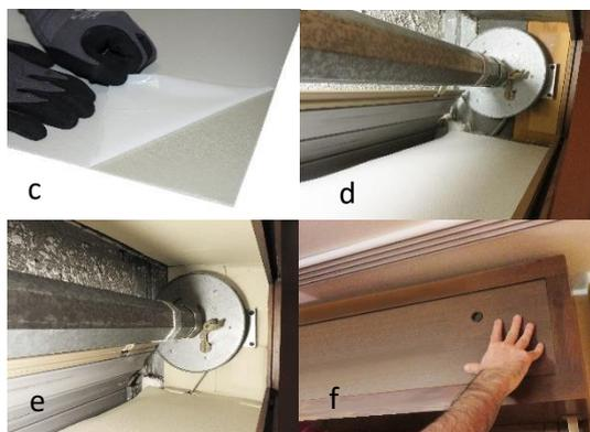
**3. Retirer lentement le film adhésif (c) et poser le matériau** sur les surfaces à isoler **(d)**. Exercer une faible pression pour faciliter l'adhésion. Dans la mesure du possible, **utiliser du matériau isolant sur toutes les surfaces du coffre** pour éviter les pertes de chaleur (ponts thermiques) et améliorer l'étanchéité à l'air et au bruit **(e)**. En replaçant le panneau amovible, **assembler le coffre** pour rétablir sa position d'origine **(f)**.
