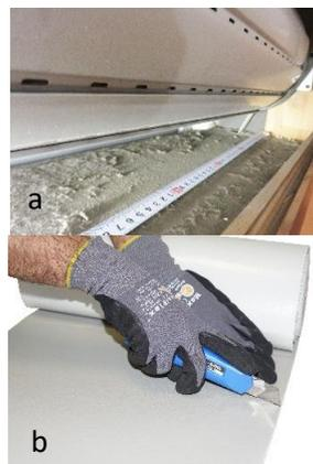
**2. Prendre les mesures** des surfaces à isoler (panneau frontal, côtés, arrière et fond) **(a)**, ainsi que calculer l'épaisseur disponible pour le matériau isolant (épaisseur entre le volet roulant, lorsqu'il se trouve complètement dans le coffre, et le panneau lui-même). **Couper le matériau isolant à la bonne taille (b).**
