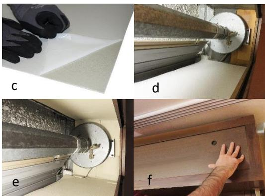
**3. Entfernen Sie langsam die Klebefolie (c) und tragen Sie das Material** auf die zu isolierenden Oberflächen auf **(d)**. Üben Sie einen niedrigen Druck aus, um die Haftung zu erleichtern.
