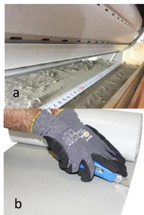
**2. Messen Sie** die zu isolierenden Oberflächen (Frontplatte, Seiten, Rückseite und Boden) **(a)** sowie die für das Isoliermaterial verfügbare Dicke (Dicke zwischen dem Rollladen, wenn er sich vollständig im Inneren des Kastens befindet, und der Platte selbst). **Schneiden Sie** das Isoliermaterial **zu (b)**.
