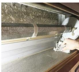
**1. Zerlegen Sie die abnehmbare Seite des Kastens und führen Sie eine erste Inspektion durch**, um deren Zustand festzustellen, und um **Schmutz, Staub und sämtliche Rückstände anderer Materialien zu entfernen**. Die Innenflächen der Box müssen sauber sein, um die Installation des Selbstklebebandes zu erleichtern.
